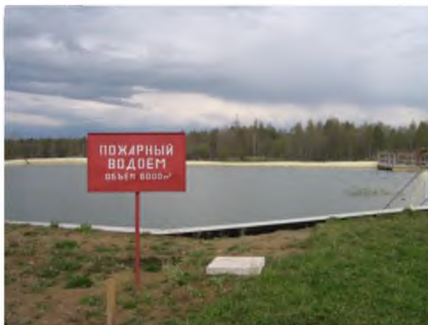
Рисунок 77. Источник (хранилище) воды, используемой при тушении пожаров.
